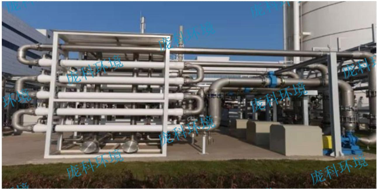
高负荷好氧脱氮膜反应器的基本原理是：管式膜或平板膜分离使污水中的大分子难降解成分，在AO生物反应器内有足够的停留时间，从而提高了难降解有机物的降解效率。反应器在高容积负荷、低污泥负荷、长泥龄下运行，可以实现很低的剩余污泥排放；同时膜能够截留几乎所有的微生物，尤其是针对难以沉淀的、增殖速度慢的微生物，因此系统内的生物相非常丰富，活性污泥驯化、增量的过程缩短，处理的深度和系统抗冲击的能力得以加强，处理水质稳定；而独特设计的高负荷AO脱氮系统保证了稳定的COD、氨氮和总氮去除效果。
