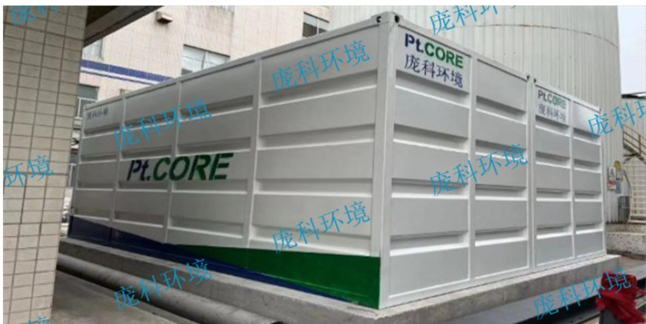
可持续发展和碳减排一直是环境保护和污水处理技术领域的重要发展目标和趋势。传统基于硝化-反硝化原理的脱氮技术不只在好氧硝化阶段需要消耗大量电能用于曝气充氧，而且需要足够有机碳源用以反硝化过程，存在高能耗、高占地、高排碳等弊端。此外，由于目前污水有机碳源不足的现象较为普遍，尤其对于经过浓缩预处理的污水，传统脱氮技术应用受到极大限制。高负荷好氧脱氮膜反应器是通过泵将AO生化池内的污泥-水混合液直接打入管式膜或平板膜内，在压力的驱动下进行固液分离，透过膜的清水进入产水箱或直接排放，而浓液再次回到生化池继续参与生化反应的一种生物反应器 $\Delta$ AO系统保证了系统对COD和总氮的去除效果，而管式膜或平板膜保证了清澈透明的出水。高负荷脱氮反应器供应商高负荷好氧脱氮膜反应器塔式的AO生化系统，负荷高，占地少。
